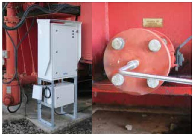
图 1. 安装的在线 DGA 监测系统 OPT100。进油管 and 出油管连接到底部的排放阀。
